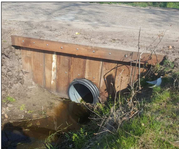
Figuur 9: Vernieuwde duiker Hollandseweg te Huijbergen
