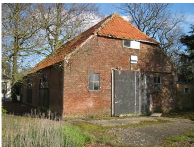
Foto 5: Te slopen oude stal
