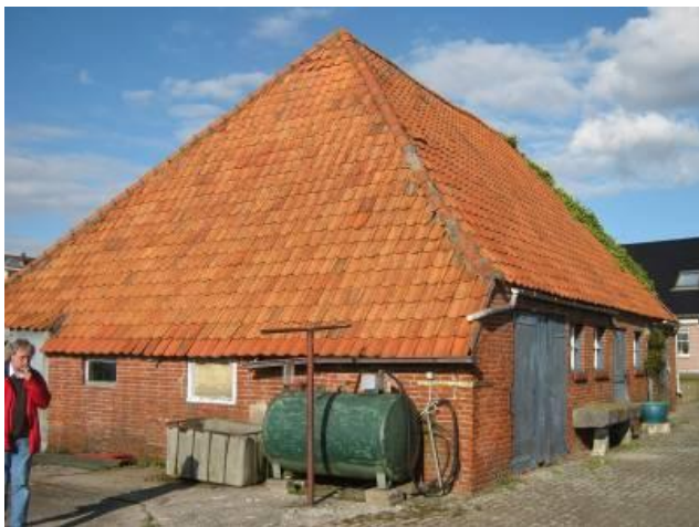
Foto 3: Te slopen werkschuur
